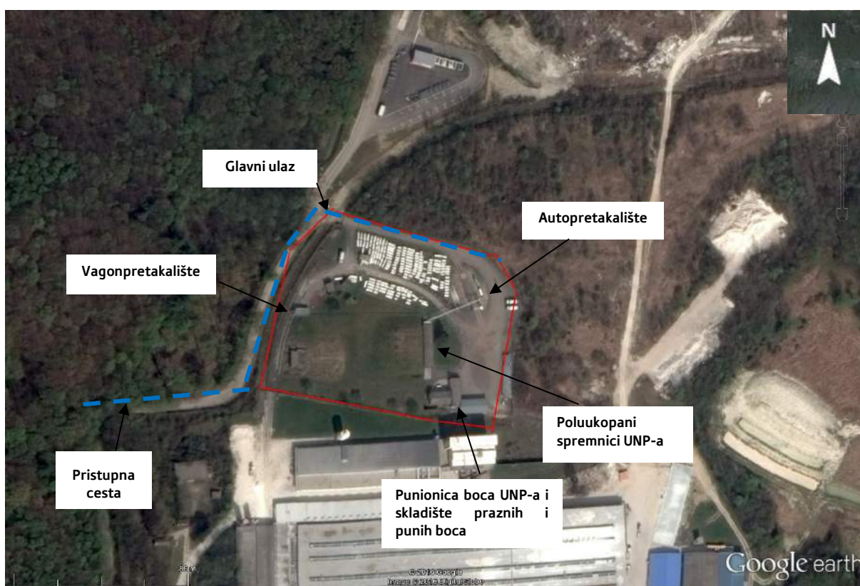
Slika 5. Dijelovi područja postrojenja Skladište Zaprešić koji predstavljaju najveće opasnosti
